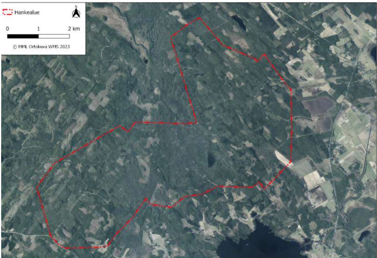
Kuva 7. Ilmakuva tuulivoima-alueesta. Alueella vaihtelevat metsämaat, suot ja pienvedet.
