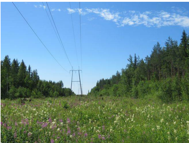
Kuva 23. Linjaus Tahkomen kohdalla lounaaseen.
