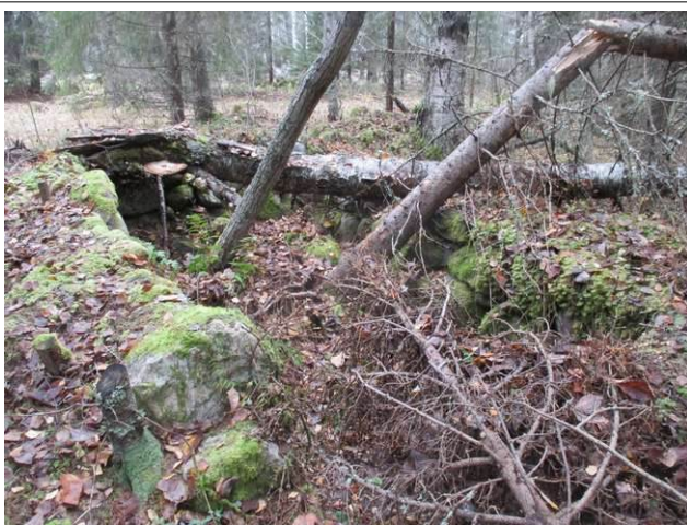
Alakohde 1-8: Kellari, kuvattu koilliseen.
