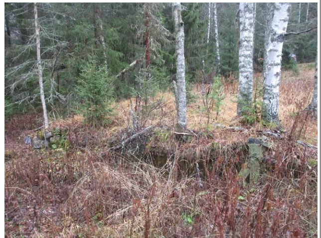
Alakohde 4-8: Uudemman rakennuksen perustus. Kuvattu koilliseen.
