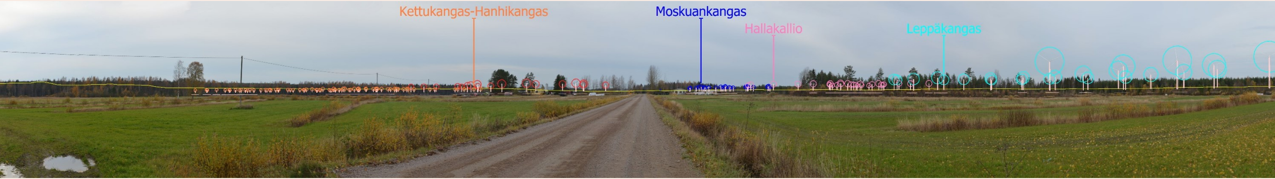
Kuva 36. Valokuvasovite kuvauspisteestä 6 hankevaihtoehdossa VE2 on otettu Liitonjoentieltä Pihtiputaalta. Etäisyys lähimpiin Uusimon voimaloihin on noin 9,8 kilometriä. Uusimon roottoriympyrät korostettu punaisella. Yhteisvaikutushankkeet Leppäkangas turkoosilla, Moskuankangas korostettu sinisellä, Hallakallio vaaleanpunaisella, sekä Kettukangas-Hanhikangas oranssilla.
