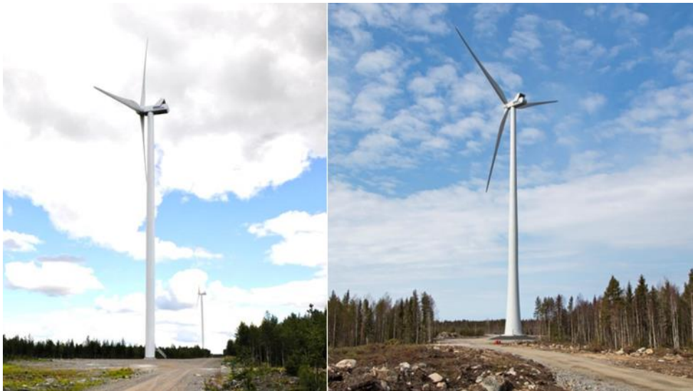
Kuva 89. esimerkki teräslieriö- (vas.) ja hybriditornista (oik.). (Kuvat: Leila Väyrynen, FCG)
