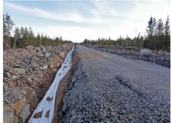
Kuva 98. Maakaapelit upotetaan huoltoteiden yhteyteen (Kuvat: FCG).
