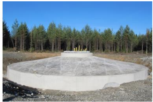
Kuva 99. Tuulivoimalan perustusten rakentamista (Kuvat: Leila Väyrynen, FCG).
