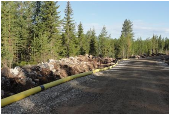
Kuva 94. Vasemmalla: Esimerkki tuulivoimapuiston rakennus- ja huoltotiestä. Maakaapeli sijoitetaan ojakaivantoon tien reuna-alueelle. Oikealla: Tuulivoimalan osia kuljetetaan erikoiskuljetuksina. (Kuvat: FCG).
