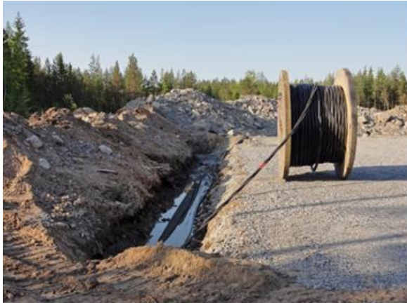
Kuva 98. Maakaapelit upotetaan huoltoteiden yhteyteen (Kuvat: FCG).
